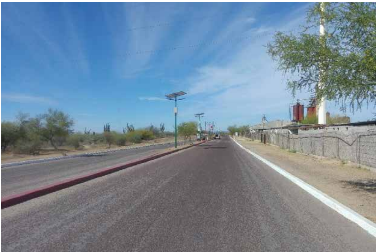
Suministro y colocación de alumbrado en el boulevard sur del Campus La Paz.
