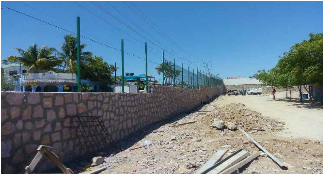
Trabajos de recuperación de la barda perimetral de Extensión Académica Los Cabos.
